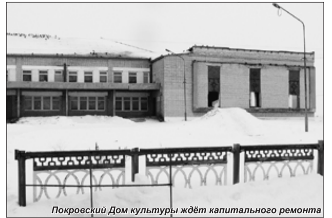
Покровский Дом культуры ждёт капитального ремонта
